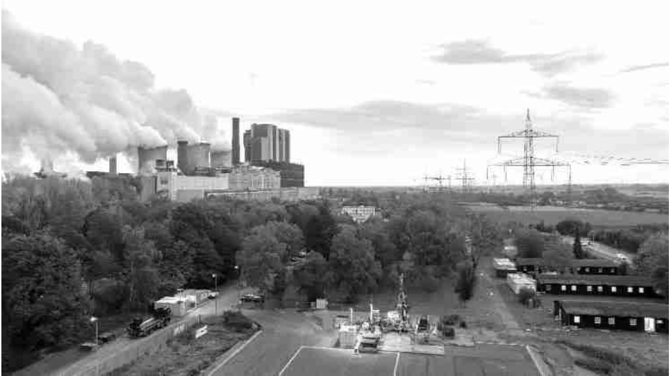
Abb. 1: Kohlekraftwerk Weisweiler (Quelle: RWE Power AG, Guido Steffen)
